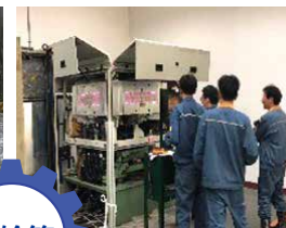
焊机激光源调试
