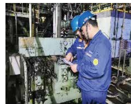
热轧卷运区域设备运行维护
